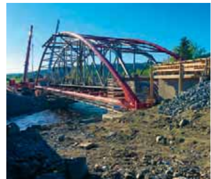
Undergurt ny bru er hengt opp under gammel bru, mens bue ny bru ligger på understøttelser stående på brudekke gammel bru.
