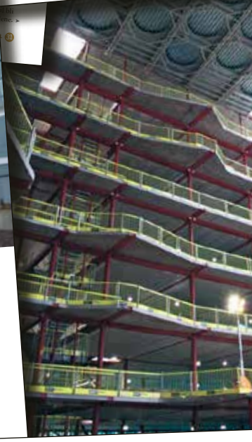
Endelig kommer den siste av over 33 000 skruer på plass. Endelig er alle de syv tusen platene over øsøpet, og de syv tusen platene på sidene på plass. Bildet er tatt sørøst i hallen.
