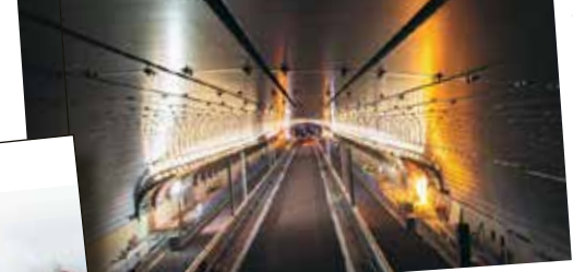
Endelig kommer den siste av over 33 000 skruer på plass. Endelig er alle de syv tusen platene over øsøpet, og de syv tusen platene på sidene på plass. Bildet er tatt sørøst i hallen.
